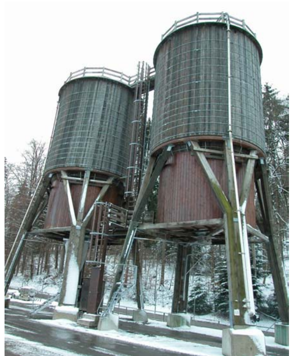
Salzsilo Anlage in Herisau (AR)
